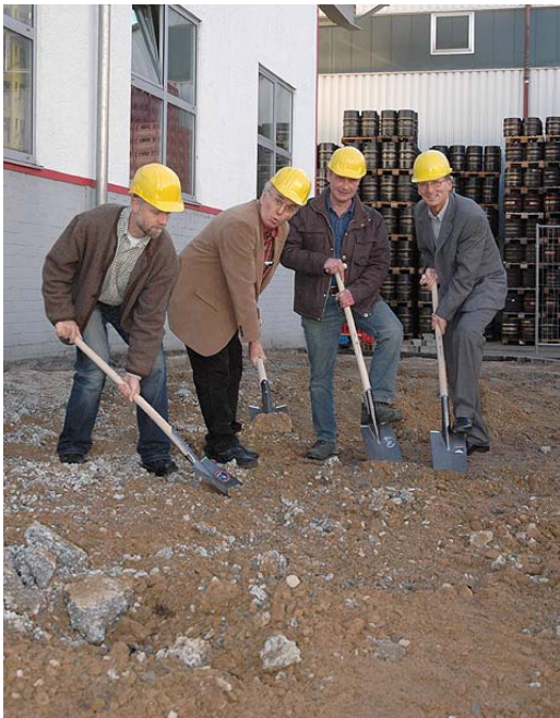
Zukunftsweisender Spatenstich bei der HEIDELBERGER Brauerei: Winfried Sahlmann (Leiter Technik), Planer & Bauausführer Bernd Gomer, Bauleiter Hansjörg Bender und Michael Mack (Gesellschafter-Geschäftsführer) v.l.n.r.
